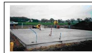
Herstellung eines Aussenaufstellungsplatzes für das Wärmepumpenmodul inkl. Rohgraben gem. Herstellervorgaben und Aufstellungsplanung.
